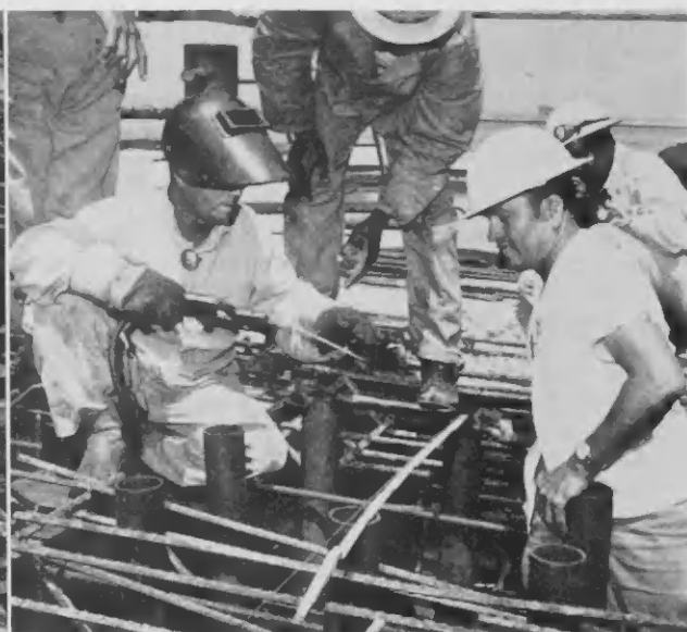
E BANDA noord di Finger Pier No. 1 a haya un renovacion mayor recientemente. Madera ariba henter largura di e waf a worde reemplazá y na unda tabatin poste di marra bapor, seccionnan nobo pa wanta bools a worde instalá y concreto a worde bashá.
